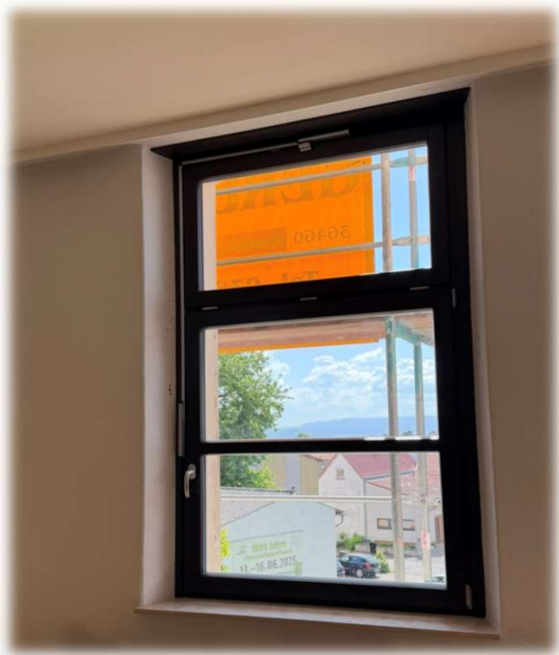
Neue Fenster – DGH Ufhausen
